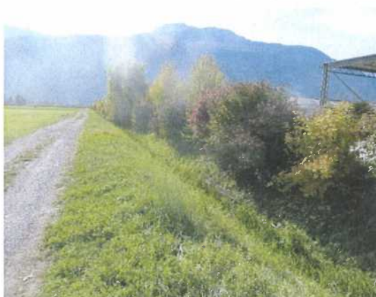
Tronçon rectiligne en aval du Manège
