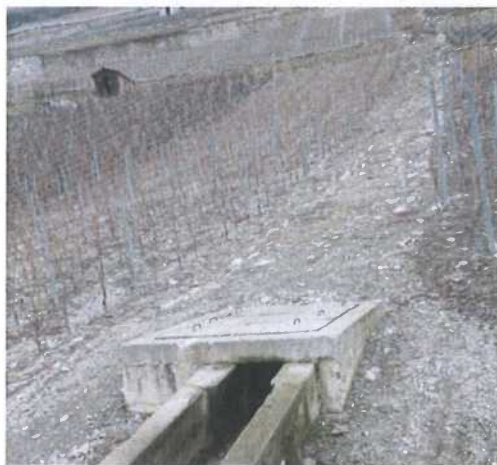
Torrent sous tuyau en aval de la route de la Creusettaz
