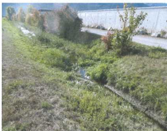
Embouchure du torrent des Plantys dans le canal du Couchant (fin de la cunette béton)
