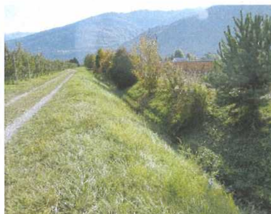
Tronçon rectiligne en amont de son embouchure avec le canal du Milieu
