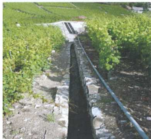
Cunette en amont de la route de la Creusettaz
