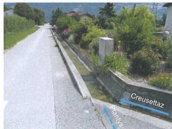
Embouchure de la Creusettaz dans le torrent des Plantys – rue de la Jonction
