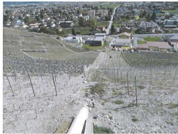
Torrent sous tuyau en aval de la route de la Creusettaz
