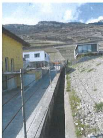
Cunette en béton à travers la zone à bâtir en amont de la RC
