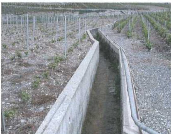
Chenal en béton sur le coteau
