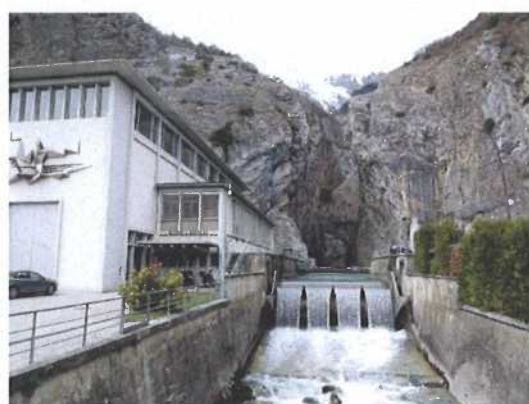
La Lizerne en aval de la centrale hydroélectrique
