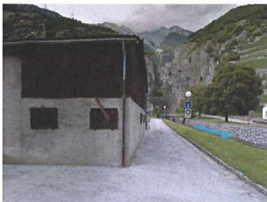
En aval de la centrale hydroélectrique
