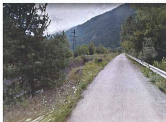
Rive droite, en amont canal Sion-Riddes
