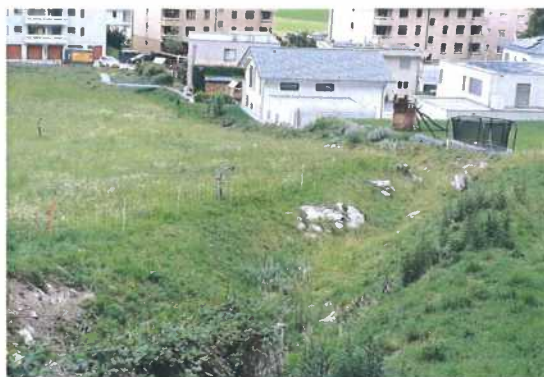
Abschnitt Low 2: Die Hochwasserentlastungsrinne liegt meistens trocken.
