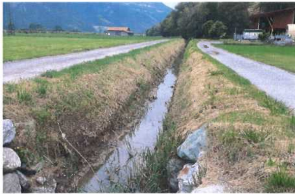
Abschnitt HOF1: Der Kanal weist gemäss Messungen vor Ort eine Breite von 1.5 m auf.
