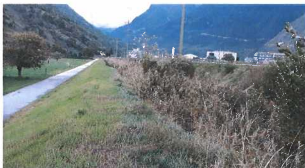
Abschnitt LAL1: Rechtsufrig schützt ein Damm dem Radweg. Die Umfahrungsstrasse befindet sich linksufrig und ist einige Meter höher gelegen.
