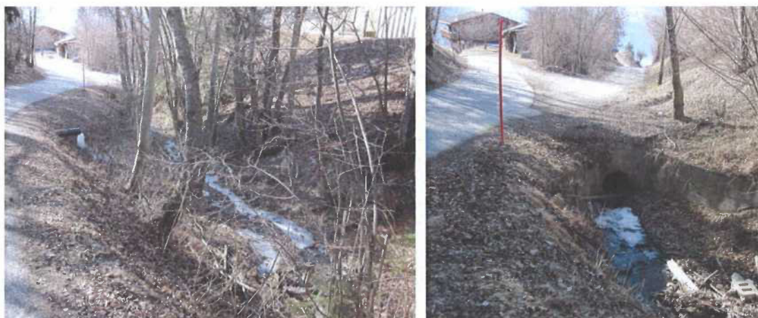
Figure 36: Creux, bordé sur les deux rives par la zone à bâtir.
