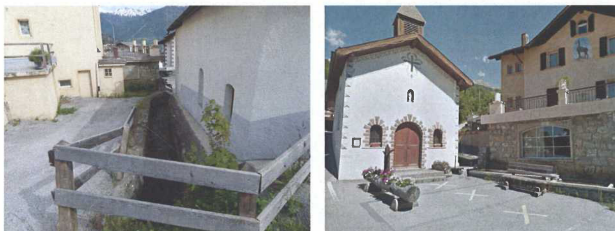
Figure 19: Botyre, canalisé avant le passage de la RC
