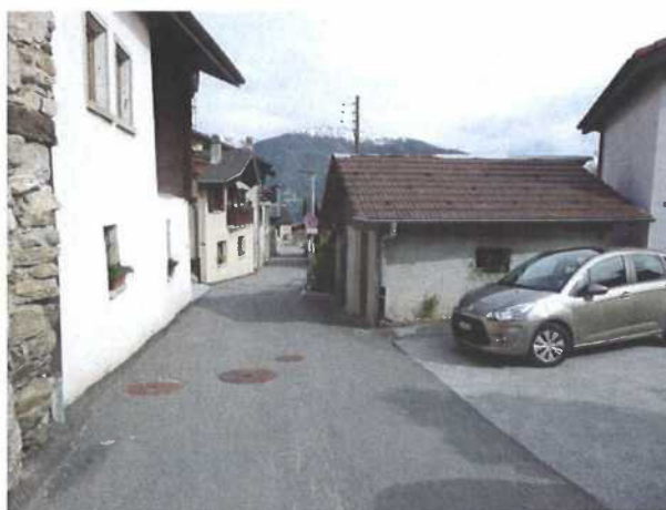
Figure 20: Botyre, sous tuyau le long de la rue du Pissieu
