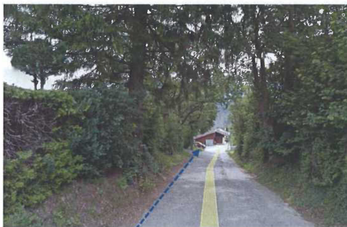
Figure 28: Creux, tronçon enterré sous la route de Villa
