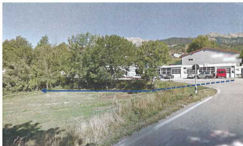
Figure 16: Croix de la Mission, tracé pour une remise à ciel ouvert, en contrebas de la route de la Madeleine.
