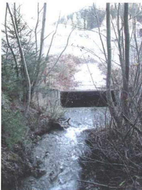
Figure 38: Pralan, passage sous tuyau en amont de la route de Pralan
