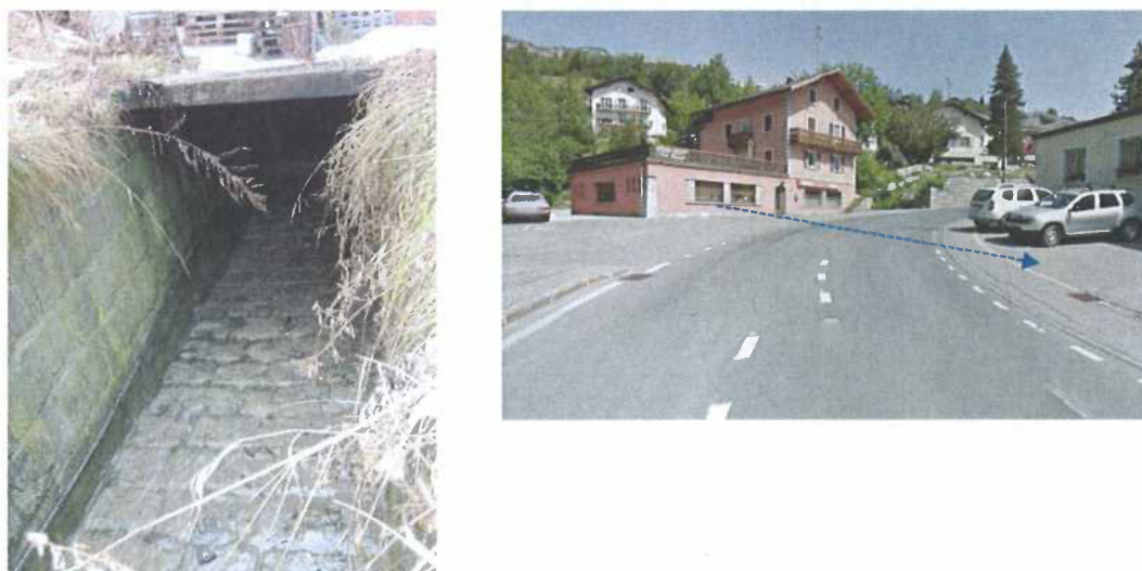
Figure 37: Grand Torrent, passage sous le restaurant du Rawyl puis sous la RC58
