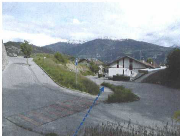
Figure 23: Saxonne, tronçon sous tuyau Rte Champ de la Grange
