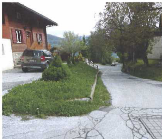
Figure 26: Saxonne, sous tuyau le long de la route de la Tuire
