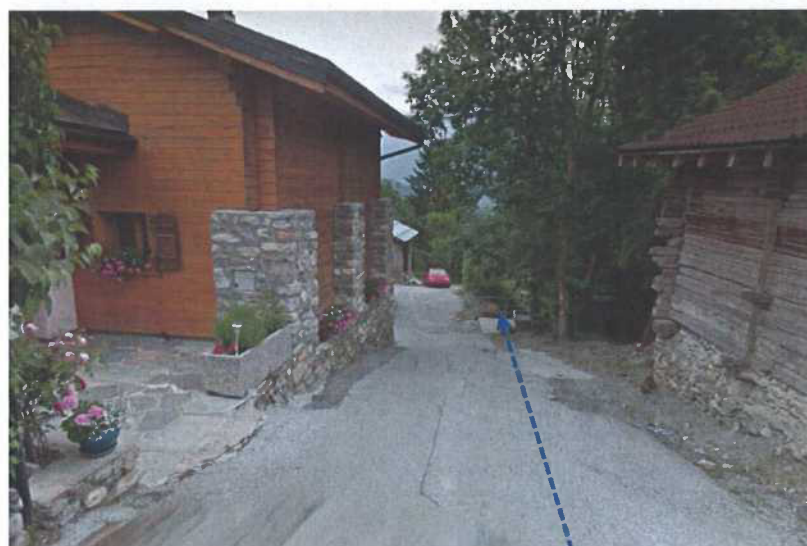
Figure 35: Creux, passage sous tuyau le long de la route du Creux
