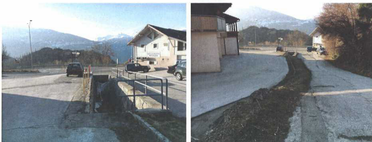
Figure 31: Creux, amont de la RC, cunette en béton et tracé sous tuyau
