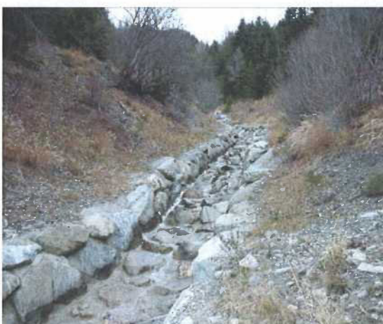
Figure 42 : Vernettes, enrochements bétonnés sur une branche des Vernettes
