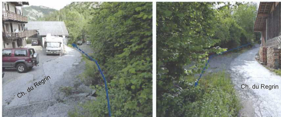
Figure 22: Saxonne, bâtiment en rive gauche à 4 m du torrent
