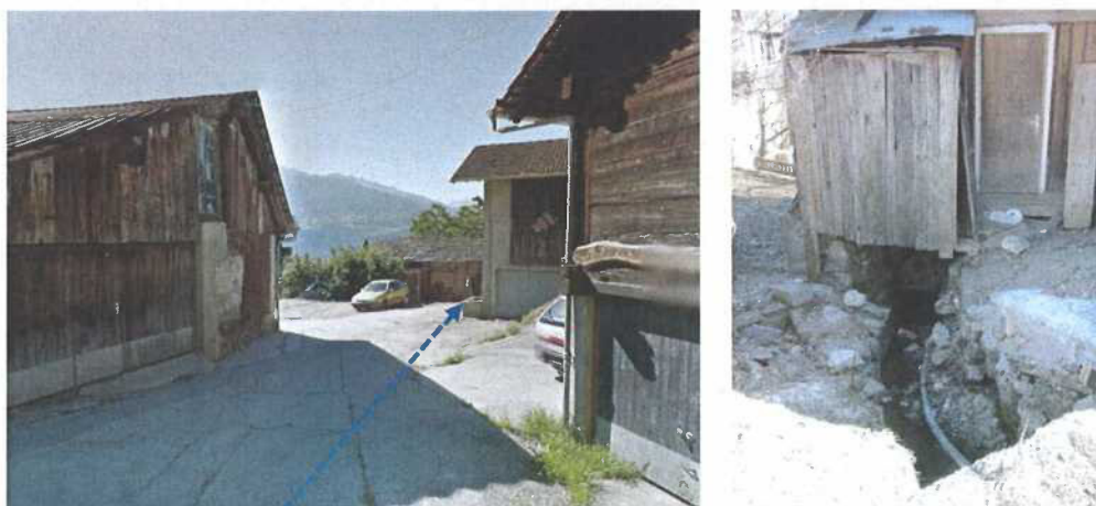
Figure 14 : Blignou, sous tuyau le long du ch. de Pétoly et passage sous un mayen
