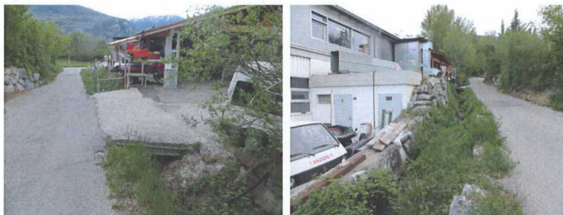
Figure 15: Croix de la Mission, passerelle d'accès et section aménagée avec constructions présentes en rive droite
