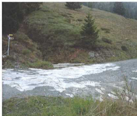
Figure 41: Pralan, passage à gué sur la route des Grillès
