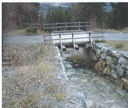
Figure 43 : Vernettes, pont de la route de Pralan
