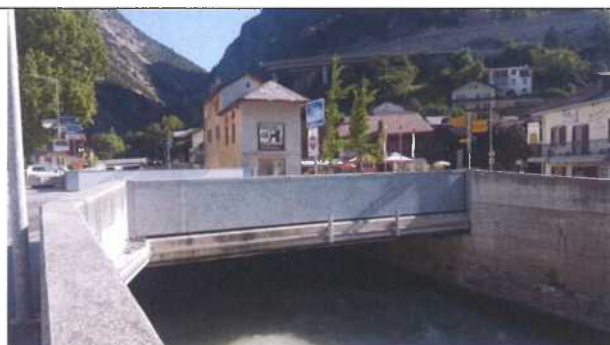
Brücke der Kantonsstrasse
