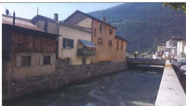
Gebäude stehen direkt am Wasser
