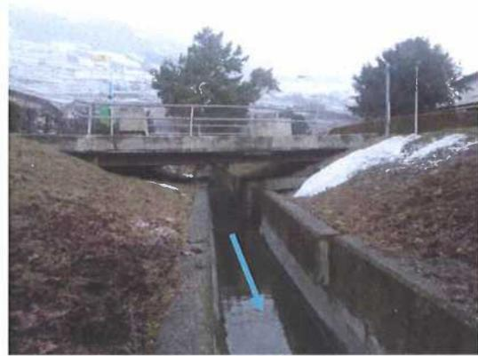
Canal du Milieu en zone à bâtir, détail sur la cunette en béton.
