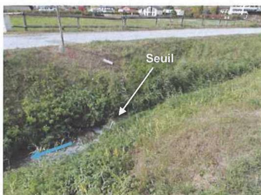
Seuil marquant la rupture de pente et donc l'embouchure du torrent des Fontaines dans le canal du Levant
