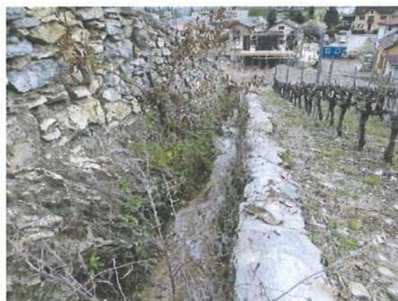
Figure 2: Chenal à ciel ouvert dans la Combe de la Creusettaz
