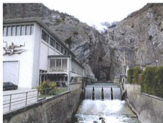
La Lizerne en aval de la centrale hydroélectrique
