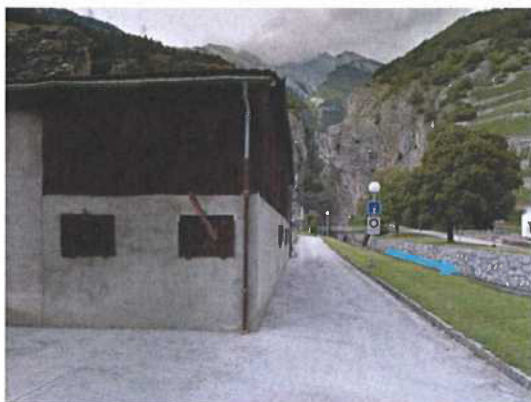
En aval de la centrale hydroélectrique
