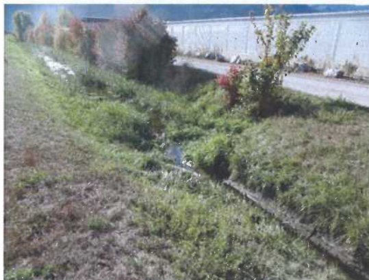
Embouchure du torrent des Plantys dans le canal du Couchant (fin de la cunette béton)
