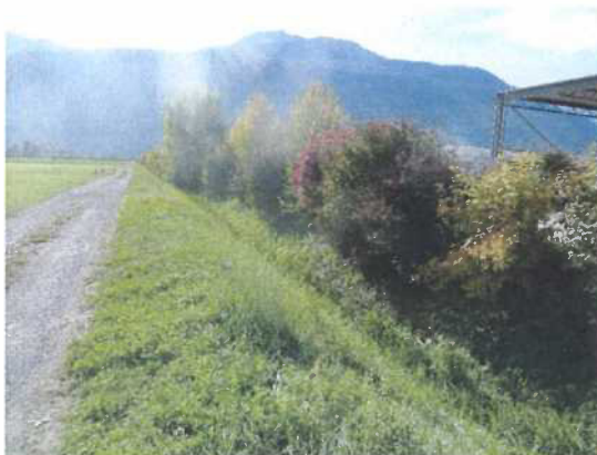
Tronçon rectiligne en aval du Manège
