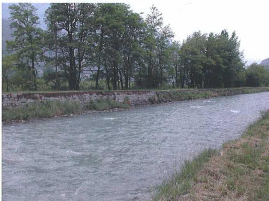
Figure 1 : Exemple de digue remblayée à l'aval du pont CFF
