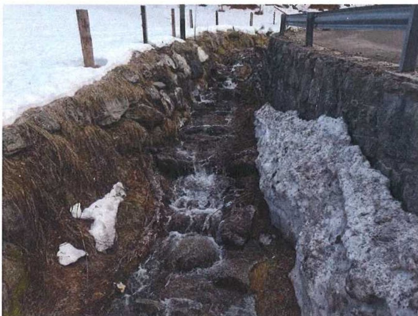
Photo 4-12 Torrent de Saint-Jean vue vers l'amont
