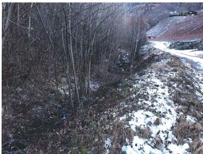
Photo 4-8 Torrent de Saint-Jean vue vers l'amont
