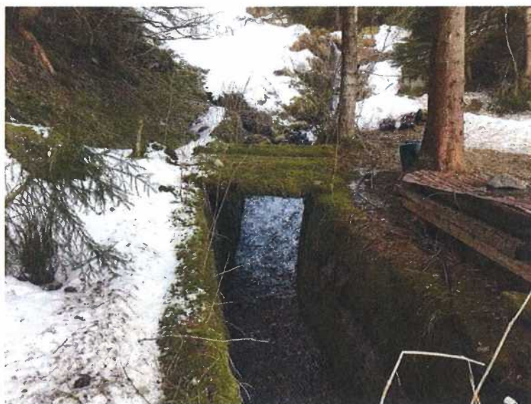
Photo 4-16 Vue vers l'amont du chenal en moellons
