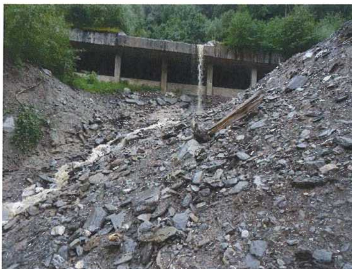
Photo 4-3 Vue sur la galerie (vers l'amont)
