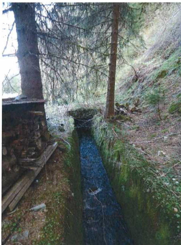
Photo 4-15 Vue vers l'aval du chenal en moellons couvert
