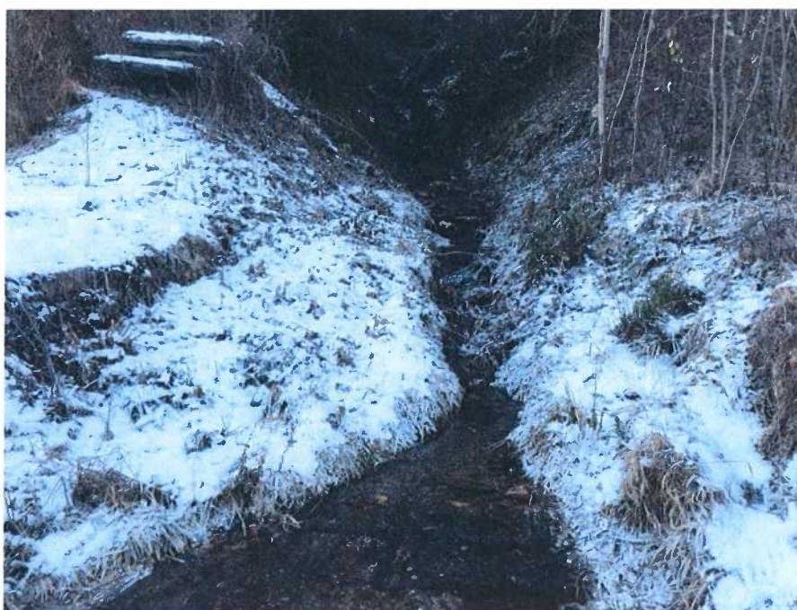
Photo 1 Torrent du Borgeaud - Vue vers l'amont
