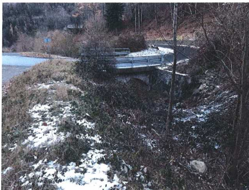
Photo 4-7 Torrent de Saint-Jean vue vers l'aval
