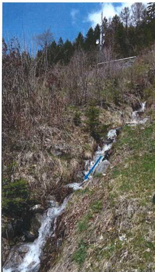
Photo 6-1 Tronçon ALE-08 (vue vers l'amont)
