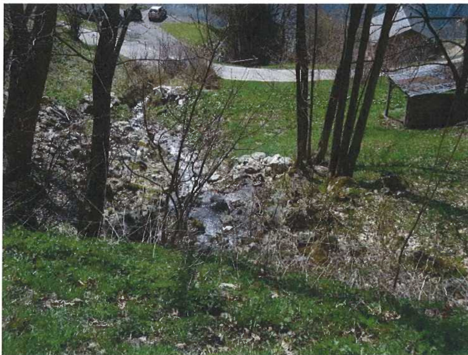
Photo 6-3 Tronçon ALE-06 partie aval (vue vers l'aval)
