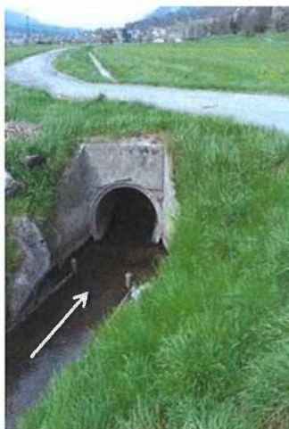
Photo 4-4 Passage sous conduite au niveau de la limite communale Dorénaz/Collonges
