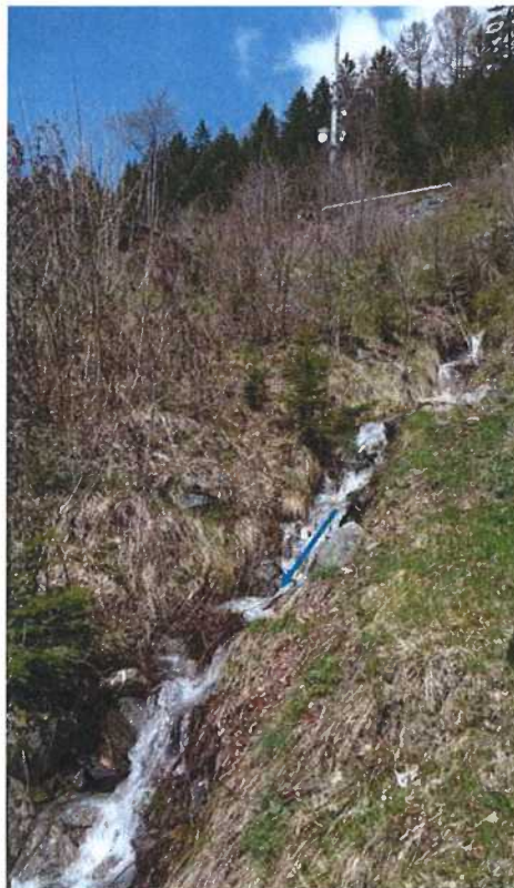
Photo 4-3 Tronçon ALE-08 (vue vers l'amont)
