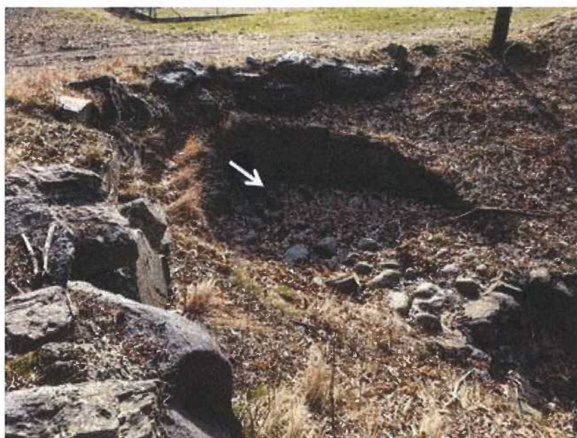
Photo 4-8 Passage sous conduite et transition entre CDC-04 et CDC-03
