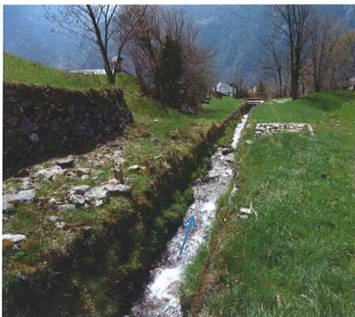
Photo 6-5 Canal en moellons avec seuils (photo de gauche vue vers l'aval) et sans seuil (photo de droite vue vers l'aval) – Secteur ALE-05
