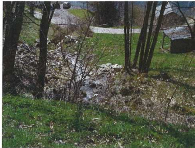
Photo 4-2 Tronçon ALE-06 partie aval (vue vers l'aval)
