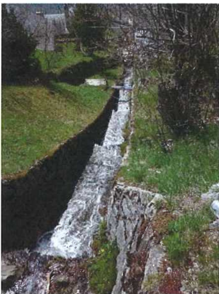
Photo 4-1 Canal en moellons avec seuils (photo de gauche vue vers l'aval) et sans seuil (photo de droite vue vers l'aval)
