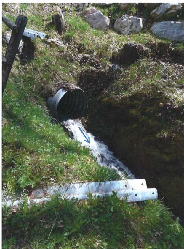
Photo 6-4 Amont du tronçon ALE-05
