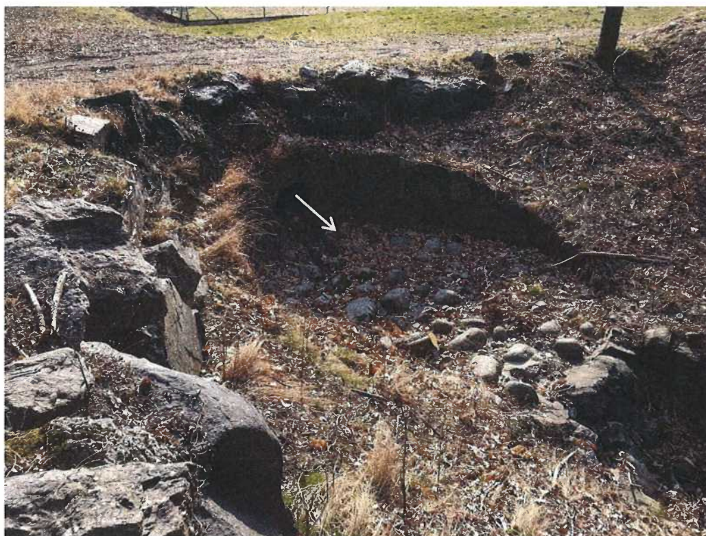
Photo 6-12 Passage sous conduite et transition entre CDC-04 et CDC-03
