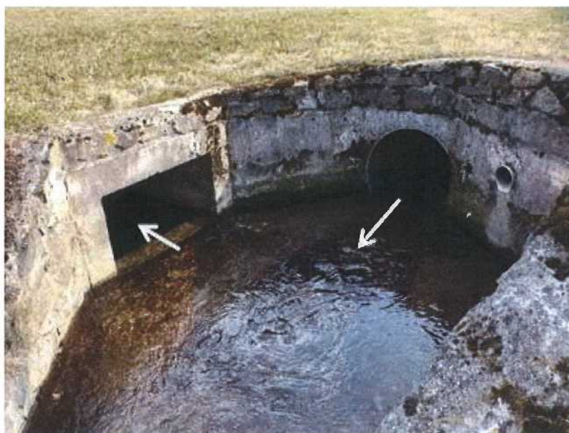
Photo 4-6 Passage sous conduite et transition entre CDC-01 et CDC-02
