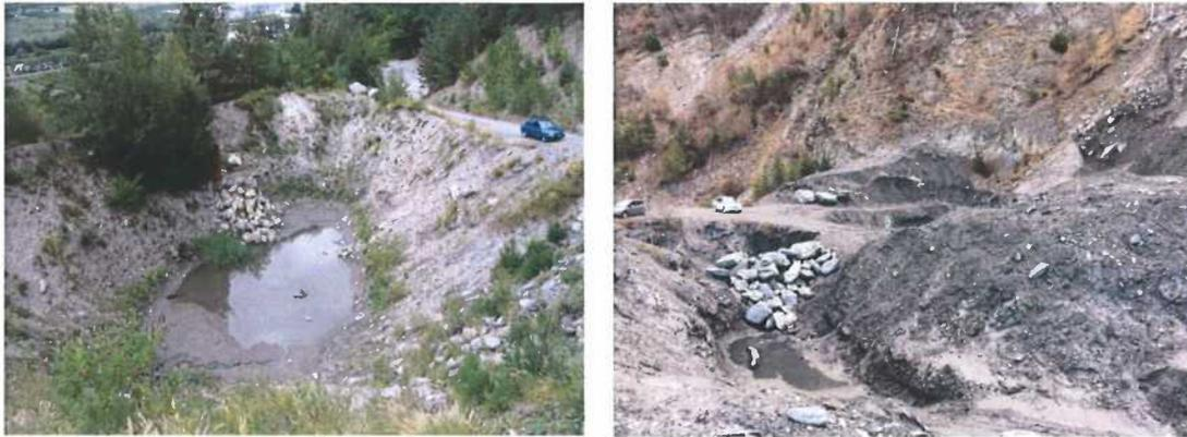
Figure 29 : ARB02-torrent d'Arbin : dessableur De2 (à gauche) et dépotoirs Dp1-2 et dessableur De1 (à droite)
