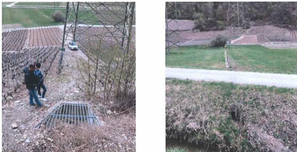
Figure 19 : MAR01-torrent des Maraîches : sous tuyau dans le coteau viticole (à gauche), et embouchure dans le canal des Maraîches (à droite)
