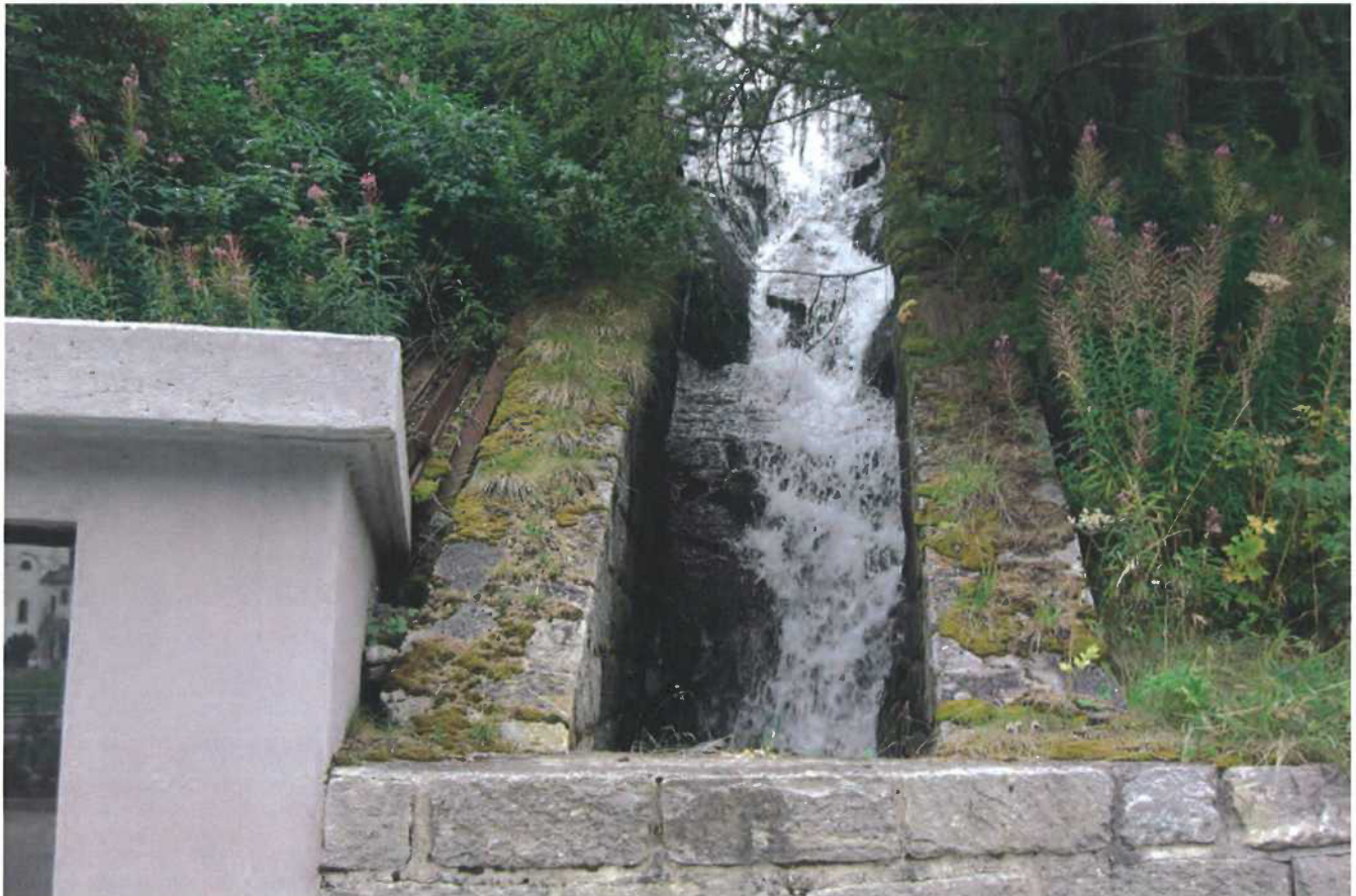
Foto bachaufwärts: Teiffgrabe kurz vor Unterführung Kantonstrasse und Einmündung in Saaservispa. Vor Ort gemessene Breite: 1m.
