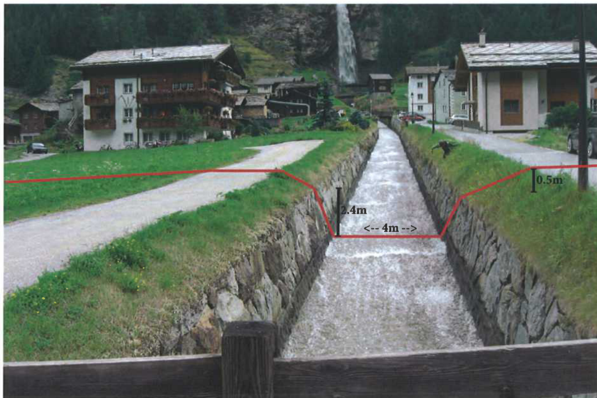
Foto bachaufwärts: Fellbach in Richtung QP FEL 1. Aktuelle Sohlenbreite: 4m
