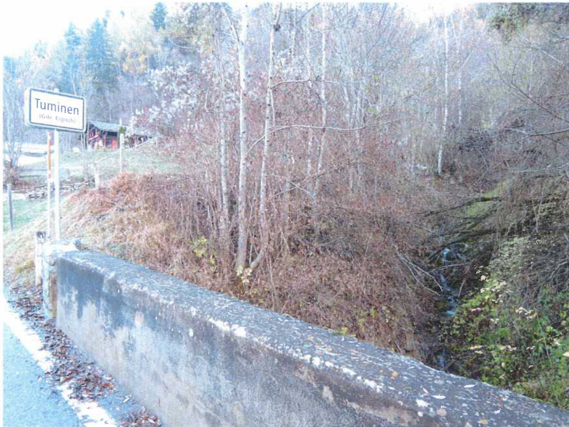
Abbildung 10: Sicht auf das Chummugraben-Gerinne ab der Brücke „Tuminen“.
