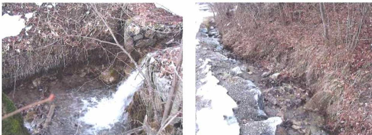
fig. 8 : affouillements du pied de berge en rive droite
