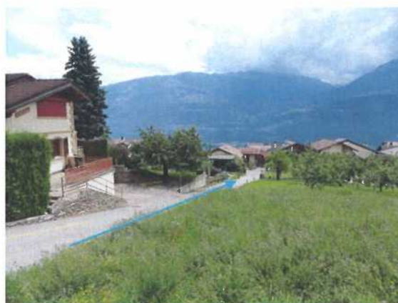
Figure 14 : Torrent des Fontaines, tronçon sous tuyau ruelle du Grépela
