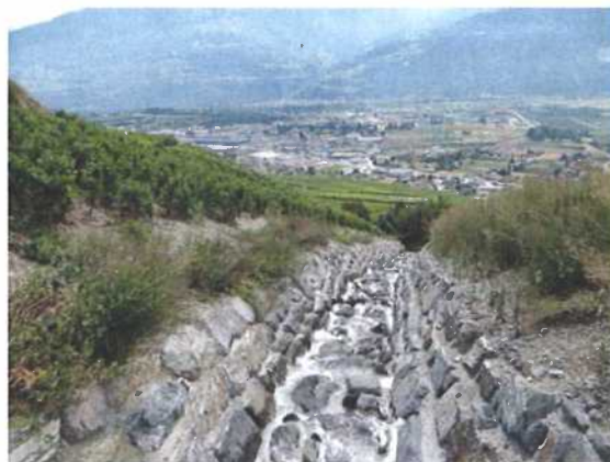
Figure 19 : Torrent des Fontaines, mesures d'urgence réalisées à l'amont de la route des vignes 660 msl
