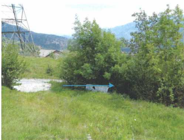
Figure 9 : Emplacement de nouveau dépotoir en rive droite du torrent
