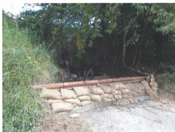
Figure 17 : Torrent des Fontaines, au niveau du rejet de la STEP
