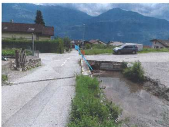
Figure 13 : Torrent des Fontaines, sortie du dépotoir Tsandoute
