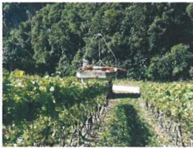
6140-MAI-01 (06.16) Ouvrage de sortie partie enterrée
