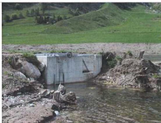
Abb. 7: Schacht für Seeabfluss, links Grundablass, Überlaufschieber rechts noch nicht montiert (Foto St. Walther 20.05.2003)
