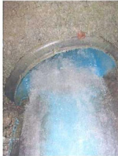
Tuyau PE annelé 500 mm, sortie à ciel ouvert
