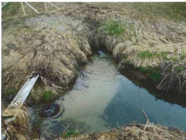
Abbildung 1: Mündung des Gifigrabens in den Flugplatzkanal, Blick gegen die Fliessrichtung. Der vom Gifigraben eingetragene helle Sand ist auf dem Grund gut ersichtlich. Der Flugplatzkanal (im Bild von rechts kommend) hingegen bringt kein Geschiebe.
