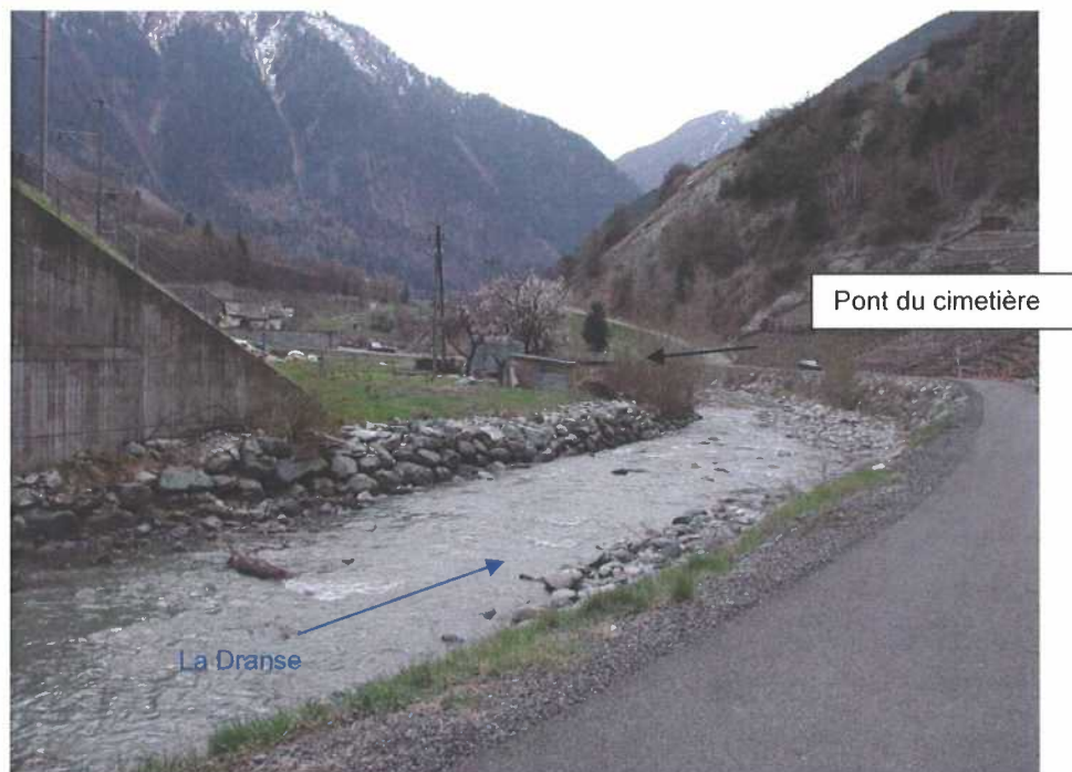
Figure 12 : DRA03, vue vers l'aval, depuis la traversée du chemin de fer
