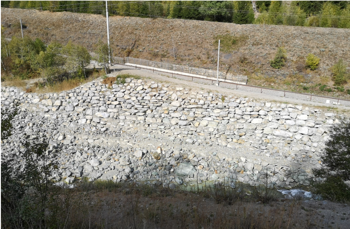
Fig. 29: Enrochement sur la rive gauche de la Mattervispa pour protéger la ligne de chemin de fer
