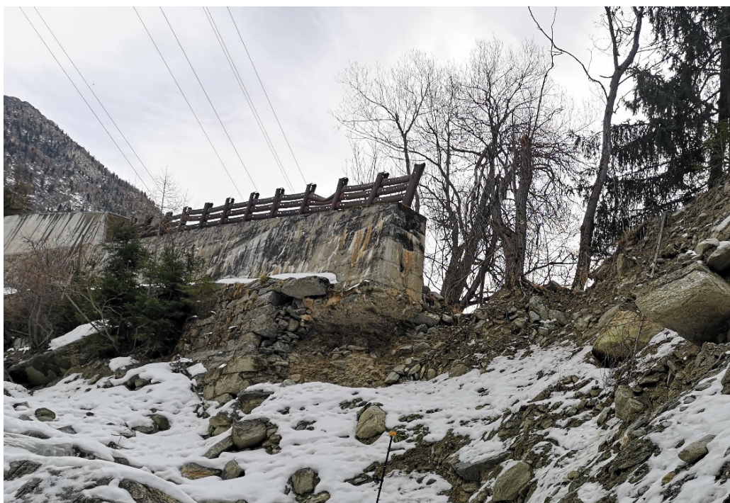
Fig. 6: mur-guide Bielzug à St. Niklaus (vue aval)
