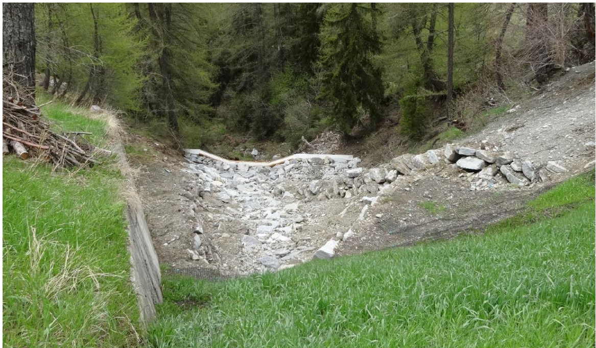
Fig. 22: rampe à blocs avec seuil de sortie du Tschingelbach
