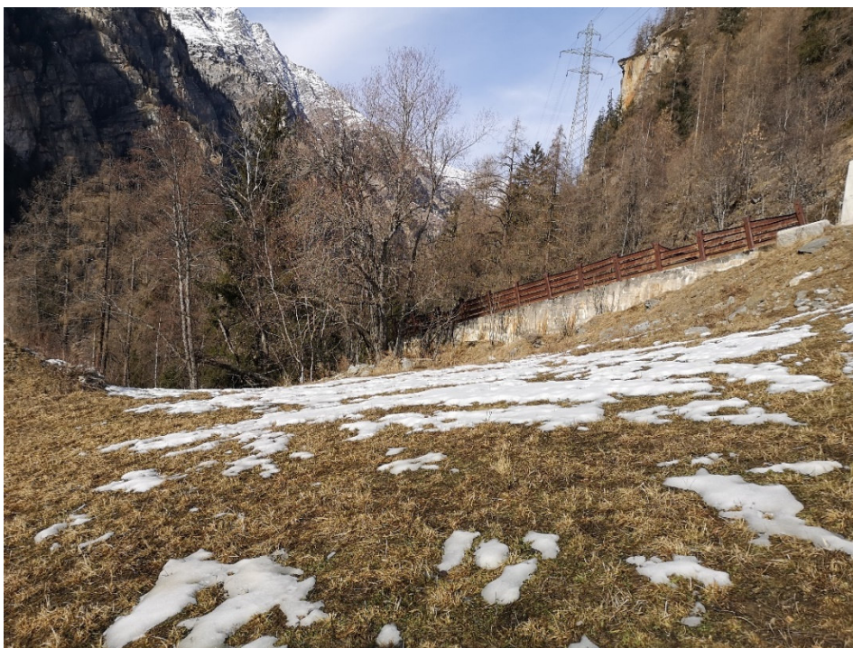
Fig. 7: mur-guide Bielzug à St. Niklaus (vue amont)
