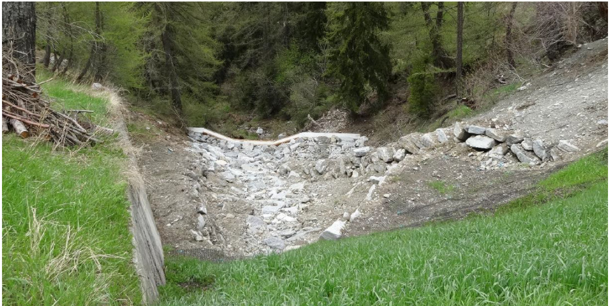
Abbildung 22: Blockrampe mit Abschlusschwelle am Tschingelbach in Jeizinen
