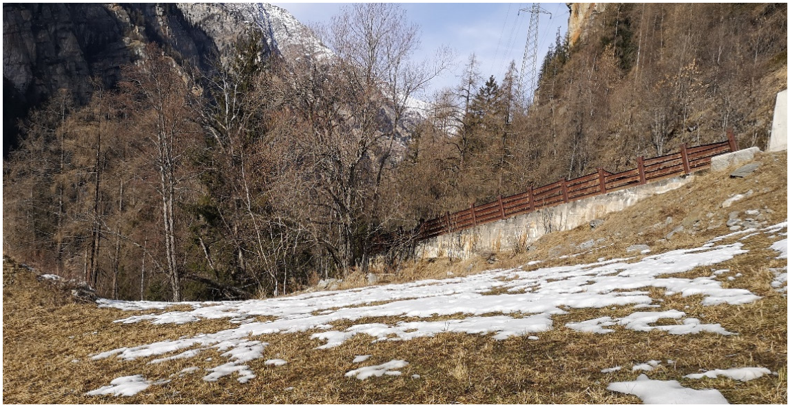
Abbildung 7: unterspülte Lenkmauer Bielzug - luftseitige Ansicht
