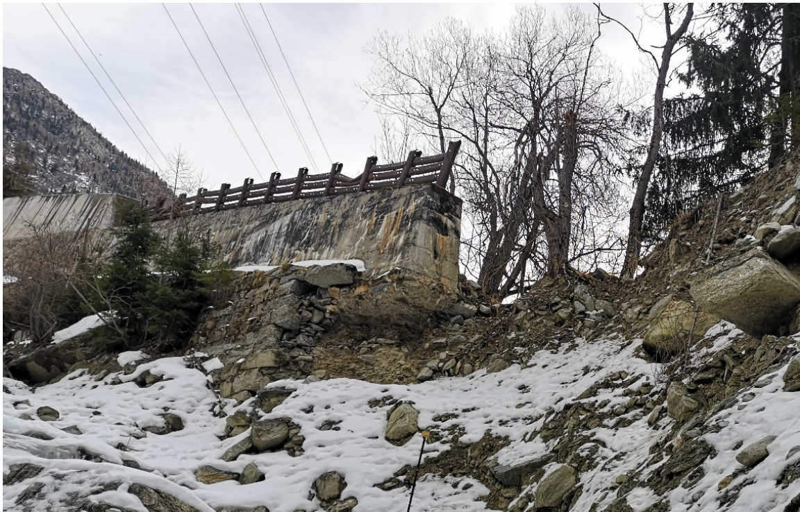
Abbildung 6: unterspülte Lenkmauer Bielzug - wasserseitige Ansicht
