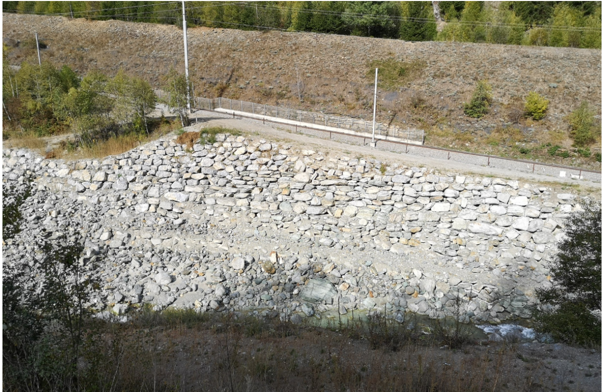
Abbildung 28: Rollierung/Blocksatz linksufrig der Mattervispa zum Schutz der Bahnlinie
