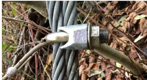
Abbildung 5: Seilklemmung bei einer DSK Grösse 22 welche nach EN 13411-5 geschmiert mit 107 Nm angezogen wurde.
