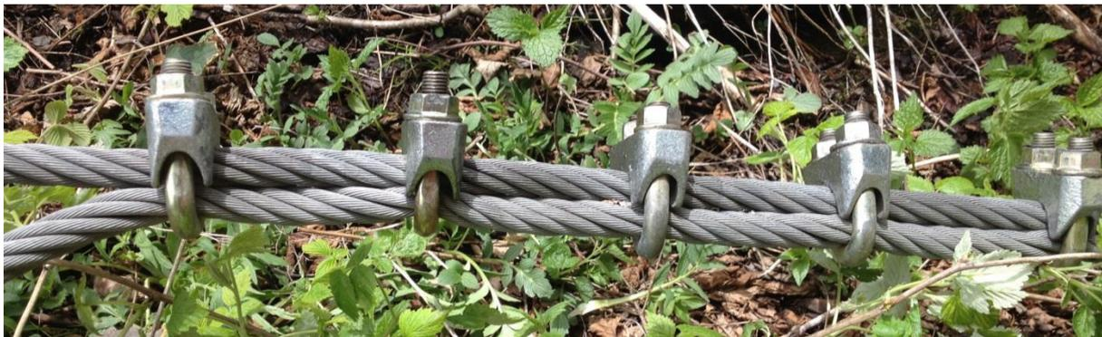
Abbildung 3: Linke zwei DSK mit richtigem Anziehdrehmoment auf geschmierten Teilen zur Kontrolle neu montiert im Vergleich zu den drei DSK rechts im vorgefundenen Ursprungszustand ohne sichtbare Seilklemmung.
