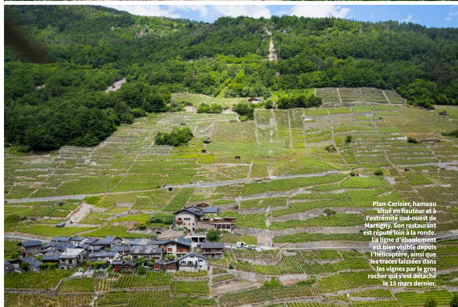
La zone la plus sensible de ce couloir d'éboulement, notamment le gros bloc «surveillé» par un extensomètre.
