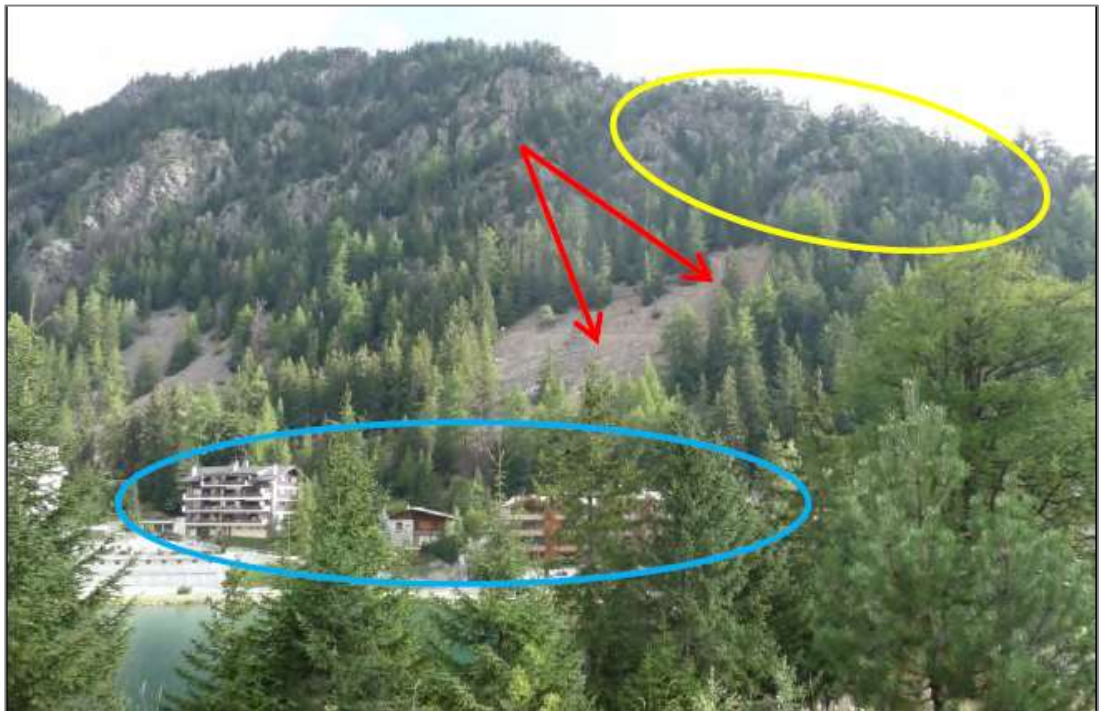
Abbildung 4: Blick auf das Ausbruchgebiet (gelb), die aktive Geröllschuttzone (rote Pfeile) und einen Teil der gefährdeten Objekte (blau). Aus [6].
