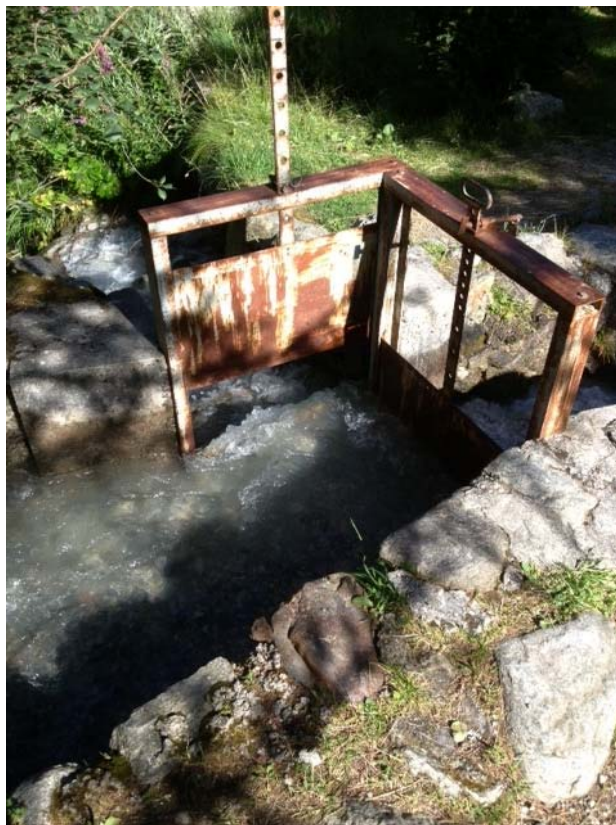
Photo n°1 - Aperçu de l'écluse permettant de régler le débit transitant par le bisse du Trient
