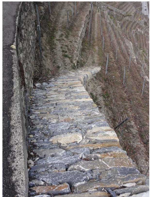
Figure 13 – Exemple de rampe en pierres sèches
