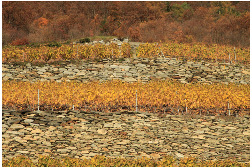
Figure 15 – Exemple type de murs en pierres sèches bien conservés
