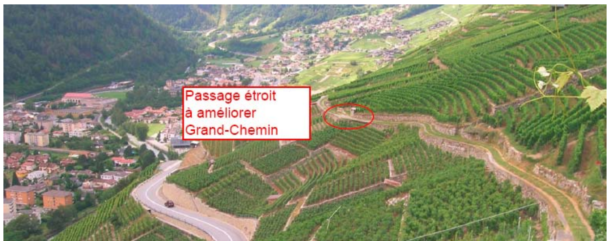
Figure 11 – Grand-Chemin, image détail du passage à améliorer
