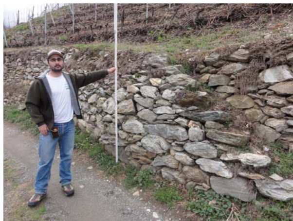
Figure 17 - Mesure de hauteur d'un parement bombé
