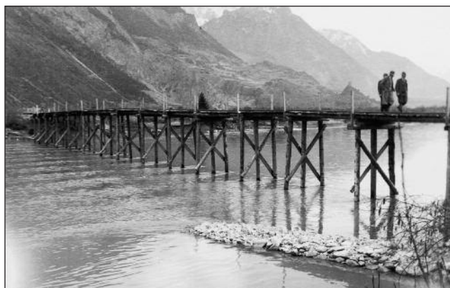
Passerelle sur le Rhône à Saxon, construite dans le cadre du remaniement parcellaire de 1932.
