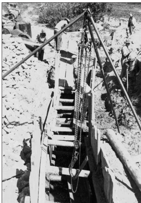
Construction de la canalisation pour l'irrigation du vignoble de Chamoson. Bau der Bewässerungs-Kanalisation im Rebberg von Chamoson.
