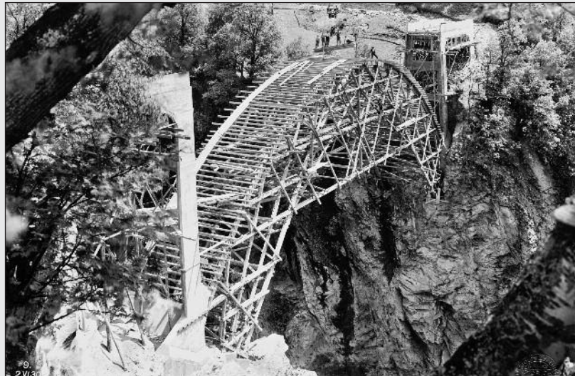
Le pont de Merjen, près de Stalden, en construction au mois de juin 1930. Merjenbrücke bei Stalden im Bau, Juni 1930.
