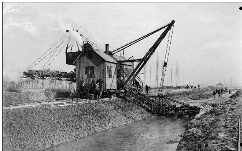
Canal Riddes-Martigny, travaux d'assainissement. Kanal Riddes-Martinach, Entsumpfungsarbeiten.
