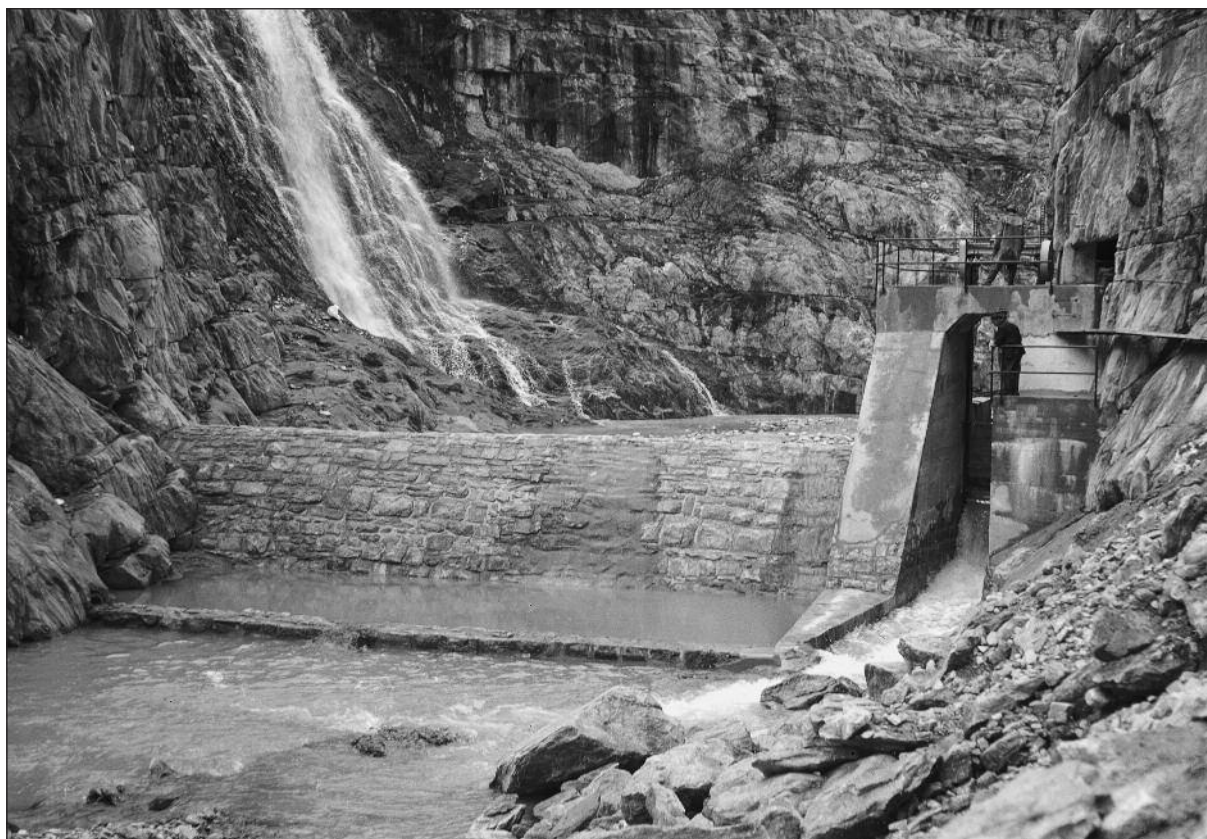
Tunnel du Riederhorn. Vue du barrage et de la prise d'eau. Riederhorn-Tunnel. Staumauer und Wasserfassung.
