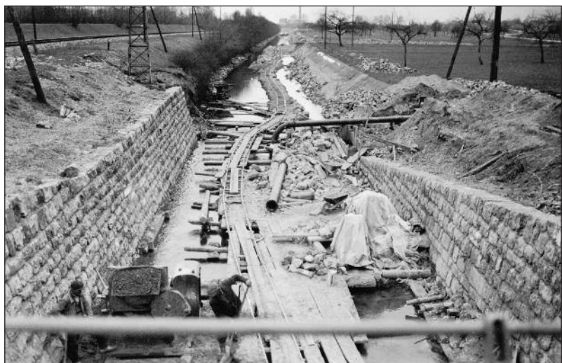
Les travaux sur le canal Stockalper tels qu'ils se présentent le 8 février 1935.
