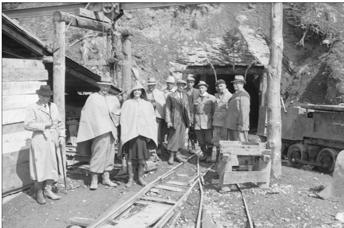
Tunnel du Mont-Lachaux. Entrée du tunnel. Eingang des Mont-Lachaux-Tunnel.
