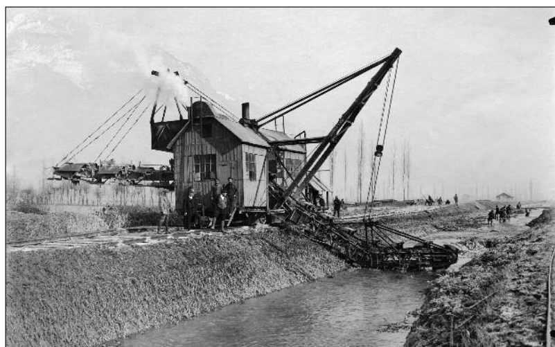
Canal Riddes-Martigny, travaux d'assainissement. Kanal Riddes-Martinach, Entsumpfungsarbeiten.
