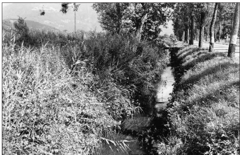
Canal Stockalper. Situation avant le début des travaux de correction en 1931, près de Collombey.
