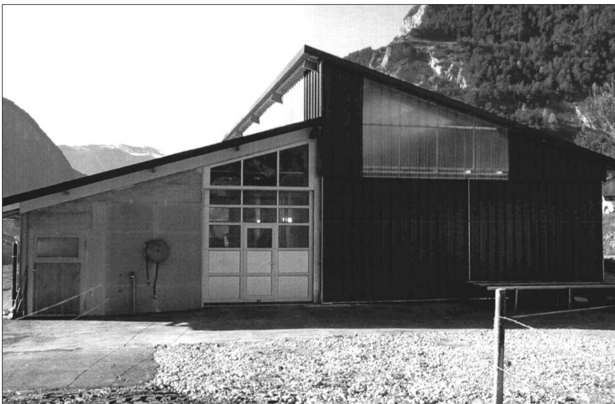
Etable de M.David Moulin, Etiez/Vollèges, terminée en octobre 2003. Stall von David Moulin, Etiez/Vollèges, fertig gestellt im Oktober 2003.
