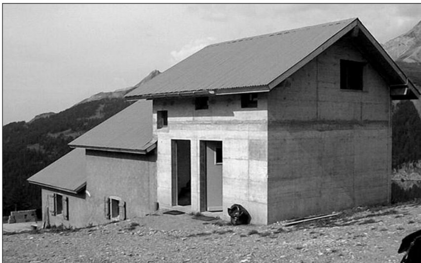
Rénovation de logis, de fromagerie, de locaux techniques d'alpage: le cas de Mondralèche, commune d'Icogne Renovation von Wohn-, Käseerei- und Technikbereich auf einer Alpe am Beispiel von Mondralèche, Gemeinde Icogne
