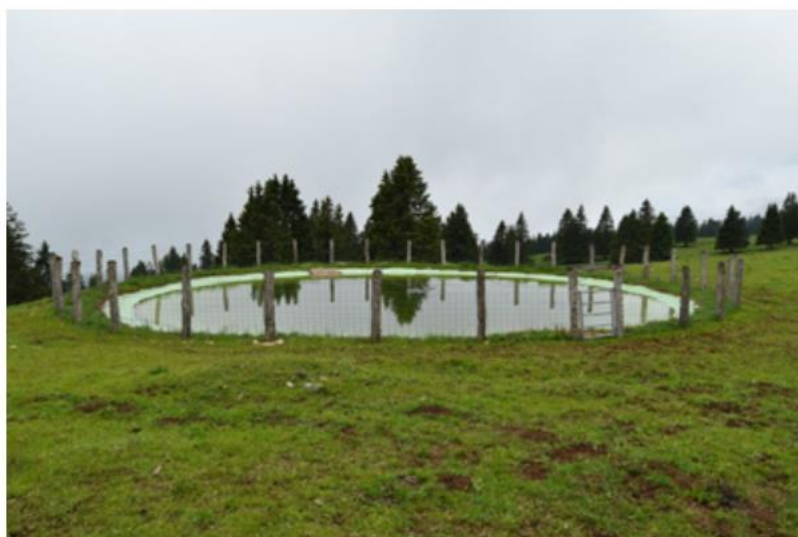
Figure 21: Un étang bâche pour stocker l'eau de pluie, Canton de Vaud [3].
