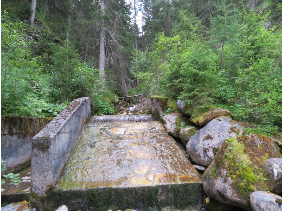
Figure 23: Exemple de vieille prise tyrolienne / « Tyrolerwehre », Combe de l'A (Foto S. Maillard, 01.08.2020).
