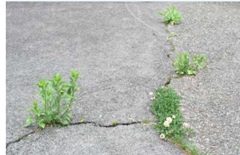
Réfection de revêtement.
