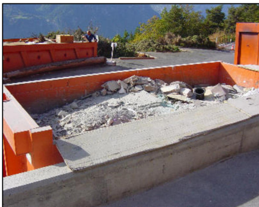
Fig. 4: Benne pour déchets de chantier minéraux.
