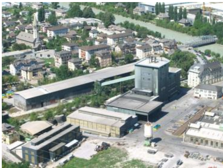
Anodenfabrik in Chippis
