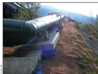
Die im Jahr 2010 eingeweihte Fern-dampfleitung, welche Prozessdampf von der Oberwalliser Kehrlicht-verbrennungsanlage Gamsen zur Lonza in Visp transportiert.
