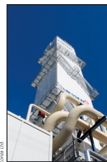
Die Lufttrennanlage auf dem Gelände der Lonza. Hier wird Luft durch Abkühlung verflüssigt. Dadurch lassen sich die einzelnen Bestandteile der Luft gewinnen.
