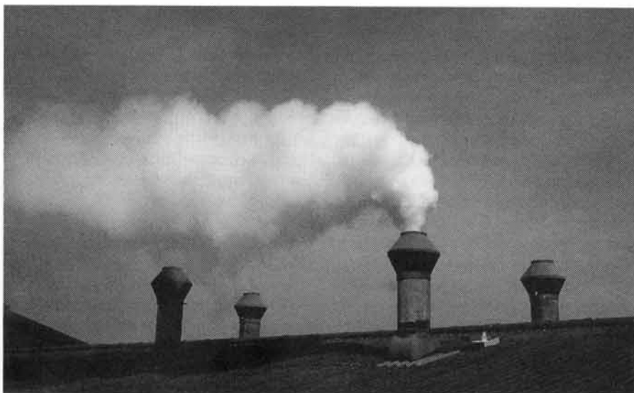
Fig. 1. Les installations d'élevage risquent d'être une source de nuisances olfactives. Par des mesures appropriées (système de stabulation, aération, alimentation, observation de la distance minimale), les émissions d'odeurs peuvent être maintenues dans des limites tolérables.
