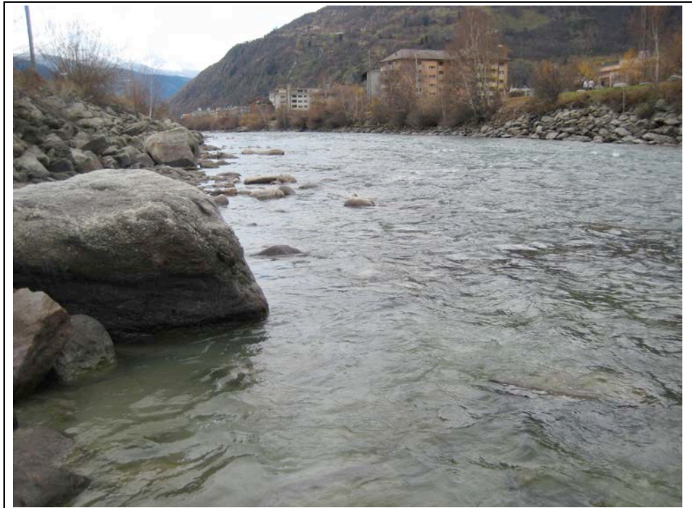
Foto 13: „RHO 120.5 Naters Fussballplatz“ (19.11.2011 Linkes Ufer)
