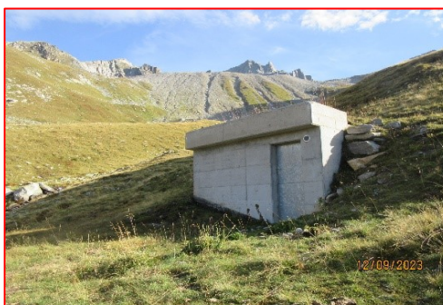
18 : Privates Reservoir für Trinkwasser © DVSV
