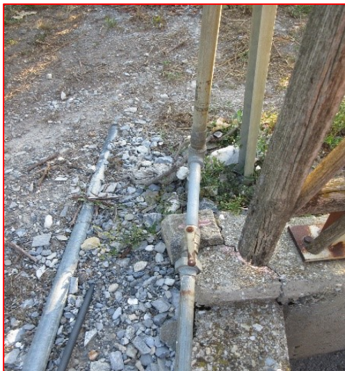
13 : Verbindungsleitungen Trinkwasser-Bewässerungssystem © DVSV
