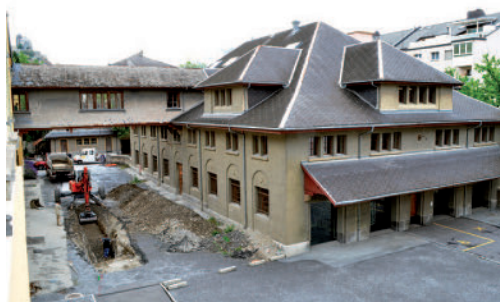
Le Centre culturel des Arsenaux abritera notamment la Médiathèque et les Archives Das alte Zeughaus Sitten beherbergt zukünftig die Mediathek Wallis und das Staatsarchiv
