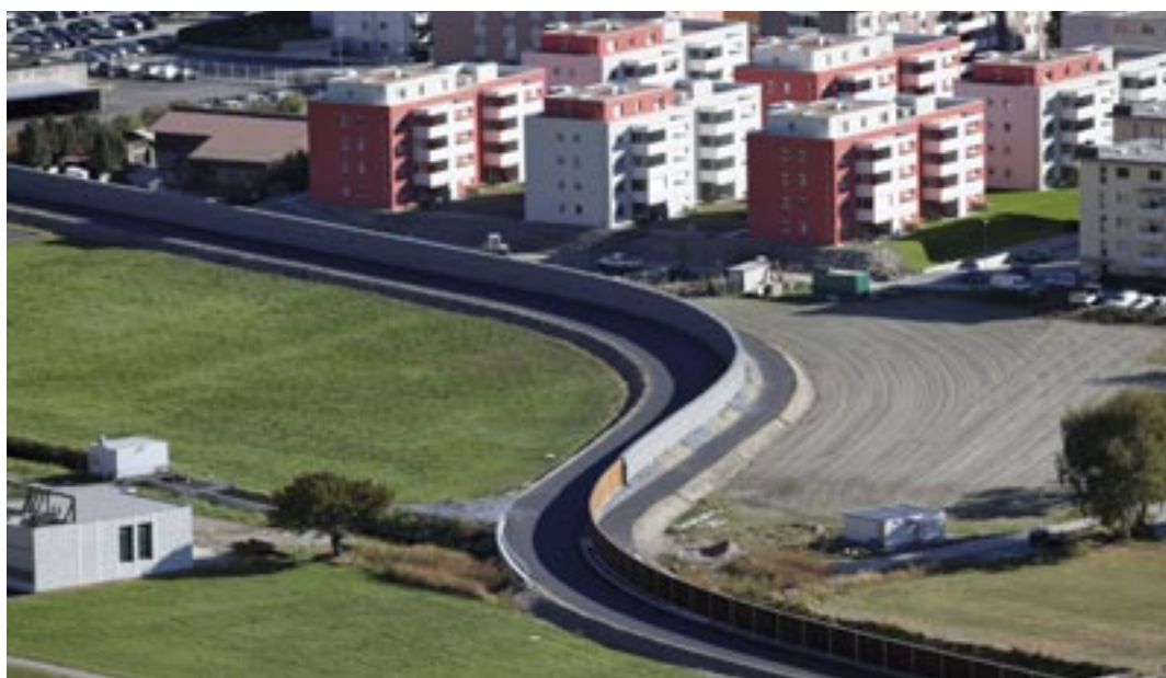
Kleegärtenstrasse à Viège: paroi antibruit Kleegärtenstrasse in Visp: Schallschutzwände
