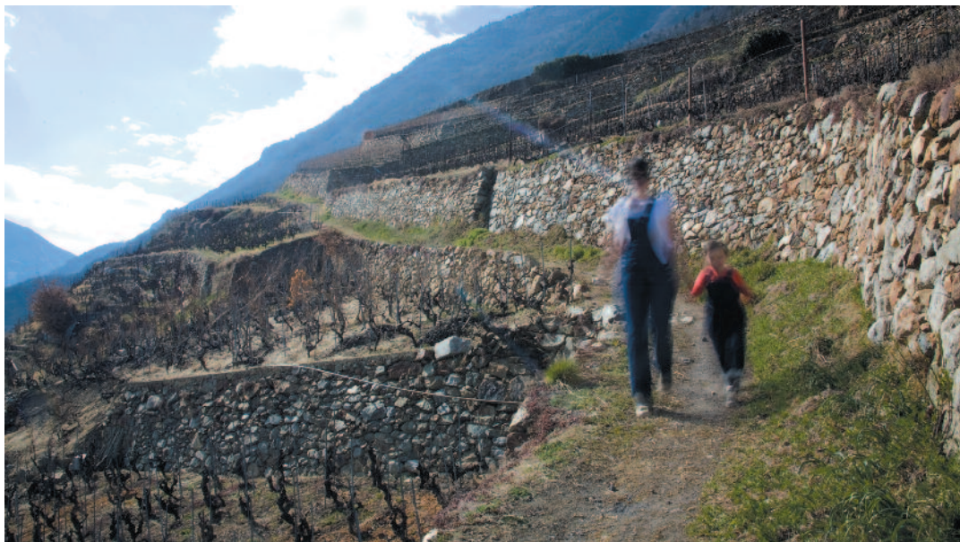
Murs en pierres sèches : d'importants crédits ont été consentis pour leur maintien. Trockensteinmauern : Es wurden umfangreiche Kredite für ihre Erhaltung gewährt.
