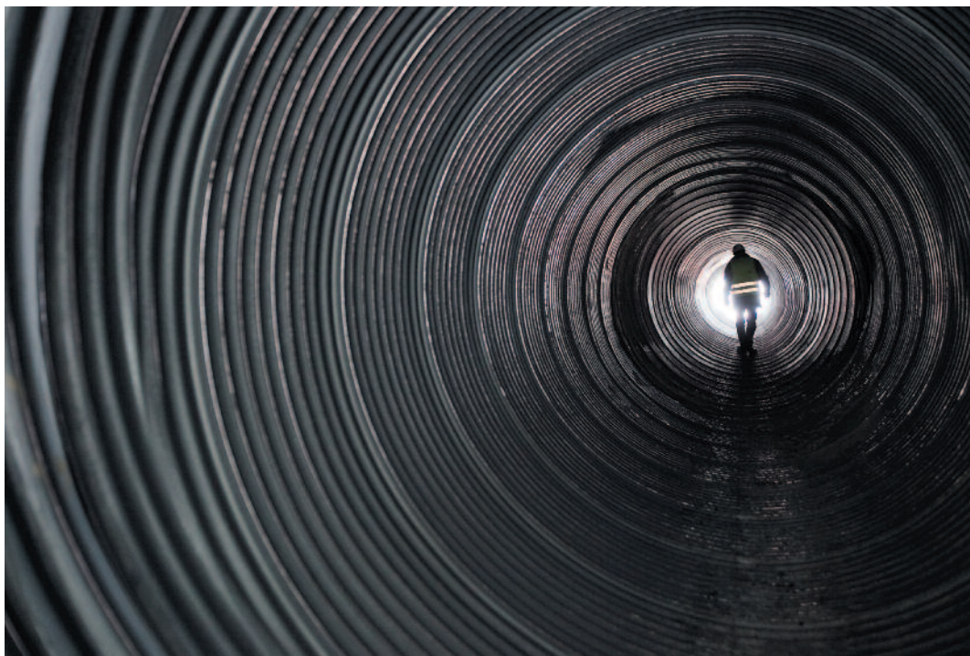
Automne 2008 - Perspective sur le chantier du Nant de Drance Herbst 2008 - Sicht auf die Baustelle Nant de Drance
