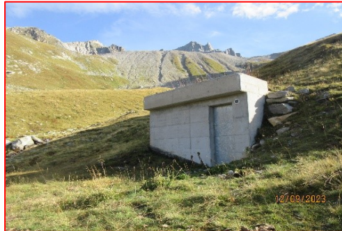
18 : Réservoir privé d'eau potable. © SCAV
