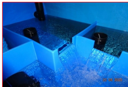
12 : Chambre de réunion d'eau de source. © SCAV
